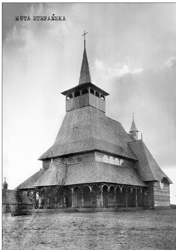
Il. 4. Kościół pw. Najświętszego Serca Pana Jezusa w Hucie Stepańskiej. Fot. z lat trzydziestych XX wieku (źródło: zbiory Obwodowego Muzeum Krajoznawczego w Równym)
