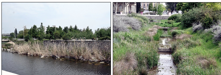
Fot. 1, 2. System retencji i remediacji wody deszczowej w parku Grand Parc des Docks
