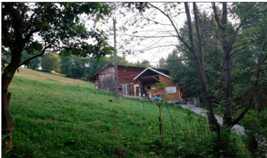
Fot. 3. Budynek zlokalizowany na terenie zagrożonym ruchami masowymi w miejscowości Obidowa (gmina Nowy Targ)
