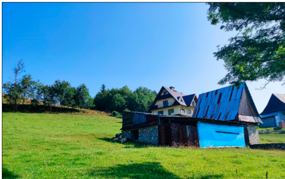
Fot. 2. Budynki mieszkalne i gospodarcze poniżej skarpy głównej okresowo aktywnego osuwiska w Gliczarowie Górnym (gmina Biały Dunajec)
