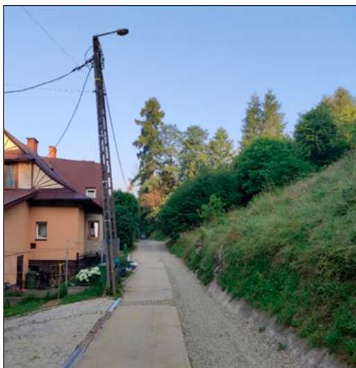
Fot. 4. Budynki znajdujące się poniżej czoła aktywnego osuwiska przy ulicy Słonecznej w Nowym Targu
