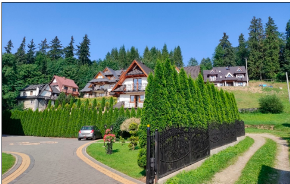
Fot. 1. Przykład budynków zlokalizowanych w granicach aktywnego osuwiska w miejscowości Biały Dunajec
