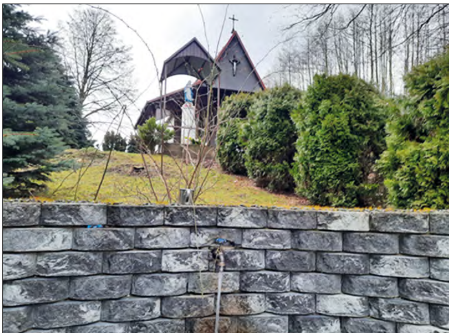
Fot. 26. Na pierwszym planie wylewka ze studni zlokalizowanej w altanie widocznej w oddali (fot. A. Zieliński, 2023)
