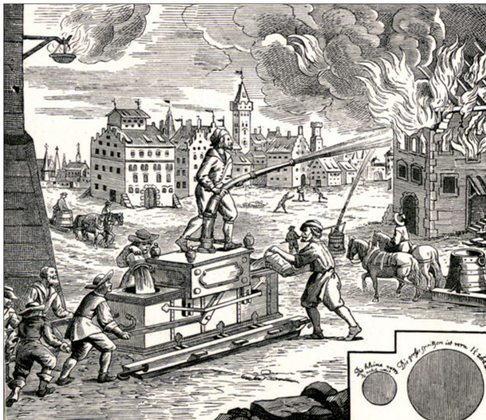
Ryc. 3: Przykład pompy Hansa Hautscha (1661).
