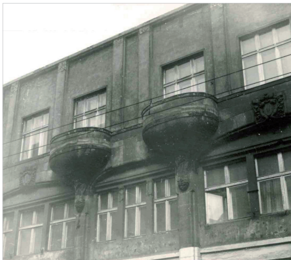
Ilustr. 12. Fasada kamienicy przy ul. 27 Grudnia 6 przed rozbiórką, kwiecień 1978 r. zbiory Miejskiego Konserwatora Zabytków; fot. I. Sajkowska
