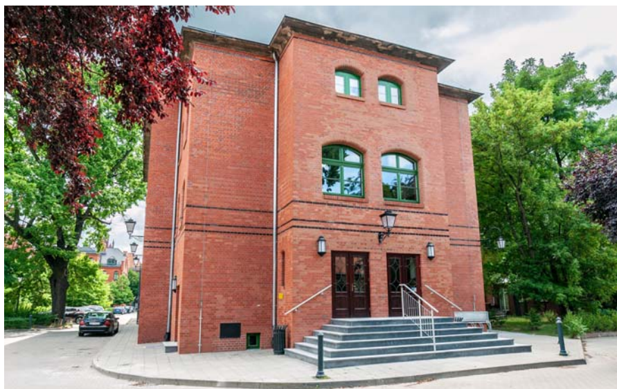
Fot. 8. Odnowiony budynek Mikrobiologii Źródło: Tomasz Walów
