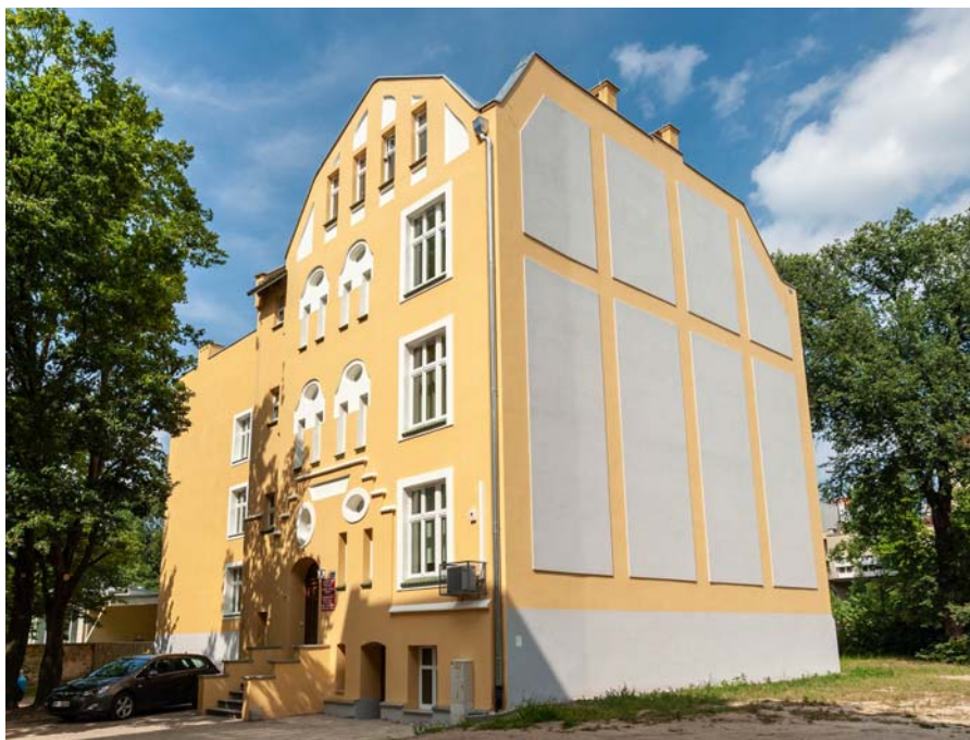
Fot. 5. Odnowiony budynek Biologii Źródło: Tomasz Walów
