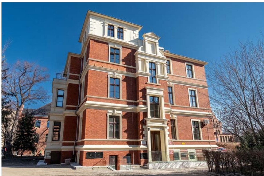
Fot. 6. Odnowiony budynek Chirurgii Szczękowej Źródło: Tomasz Walów
