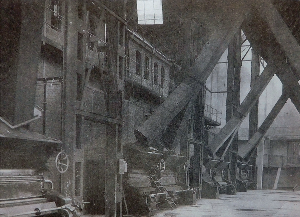
Ryc. 2. Wnętrze kotłowni – kotły typu Garbe oraz zsypy węglowe (ok. 1925 r.) (źródło: S. Piątkowski, Państwowa Wytwórnia Prochu i Materiałów Kruszących w Pionkach. Historia okresu międzywojennego, realia okupacji oraz perspektywy powojennej odbudowy zakładu w dokumentach z lat 1939–1944 , Pionki 2007, b.p.)
