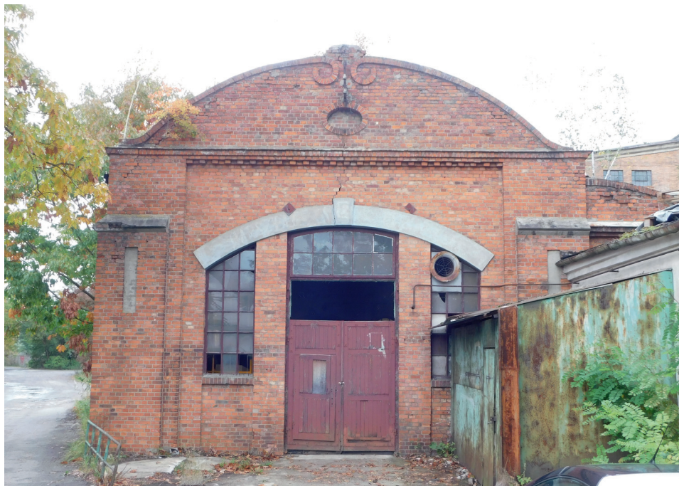
Ryc. 17. Budynek warsztatu elektrycznego, elewacja południowa (fot. B. Kozak)
