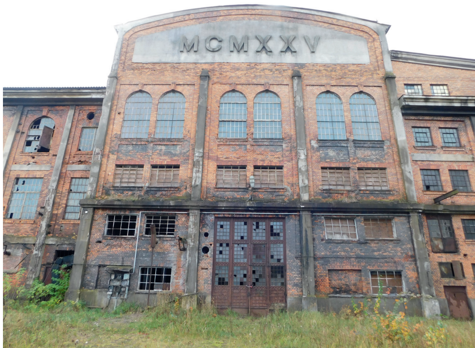
Ryc. 9. Budynek elektrowni, elewacja północna hali turbin (fot. B. Kozak)
