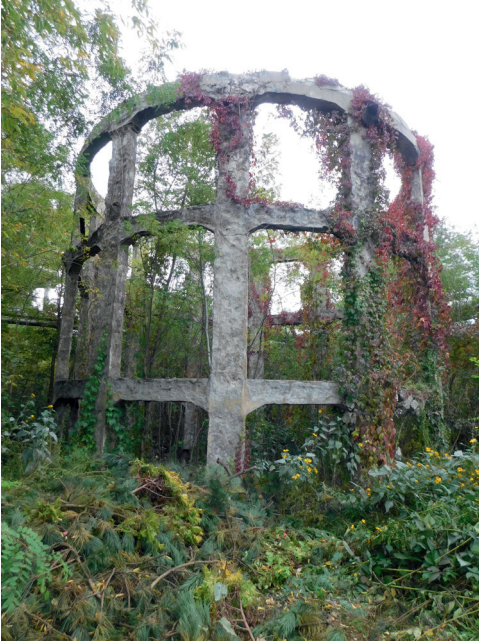
Ryc. 16. Pozostałości chłodni kominowej, widok od strony zachodniej (fot. B. Kozak)
