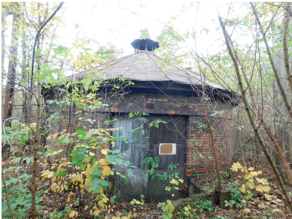
Ryc. 15. Budynek ujęcia wody, widok od strony północnej (fot. B. Kozak)
