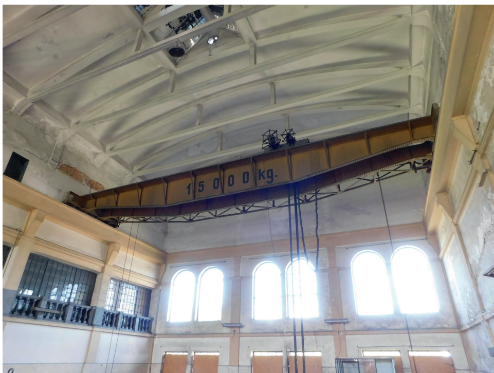
Ryc. 13. Sawnica w hali turbin (fot. B. Kozak)
