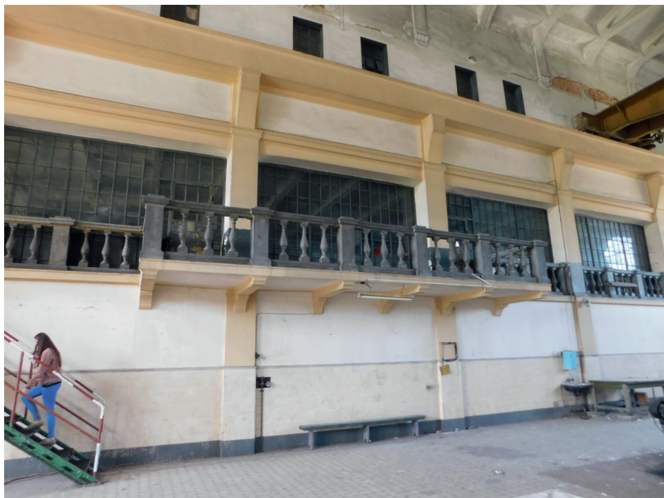
Ryc. 10. Wnętrze hali turbin, ściana zachodnia (fot. B. Kozak)
