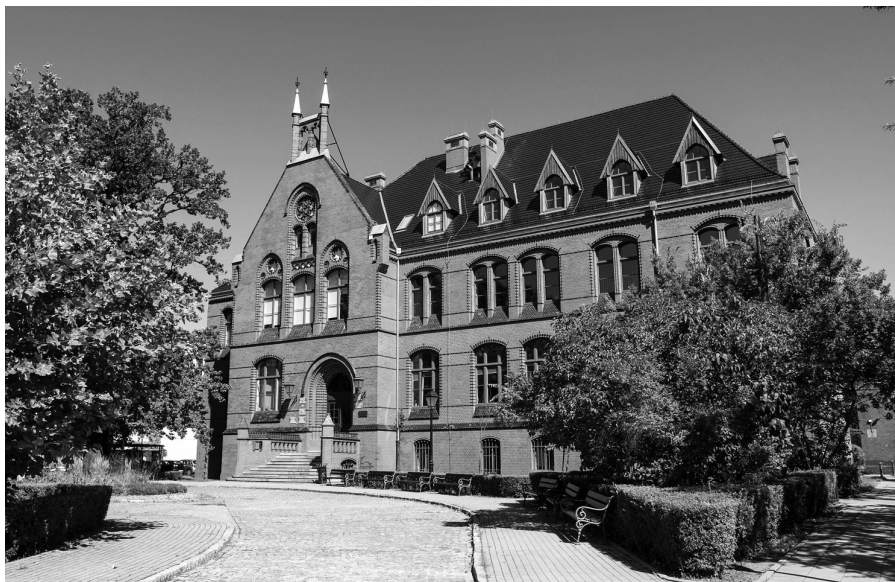
Fot. 3. Budynek Katedry i Zakładu Anatomii AM we Wrocławiu w starym kampusie uczelni przy ul. Chałubińskiego/Pasteura
