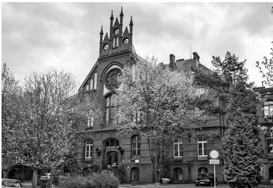
Fot. 4. Budynek Katedry i Kliniki Ginekologii AM we Wrocławiu w starym kampusie uczelni przy ul. Chałubińskiego
