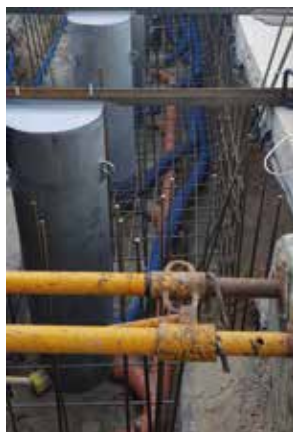
Zdjęcie 16. Przykłady prawidłowego montażu bollardów automatycznych (A i B).
