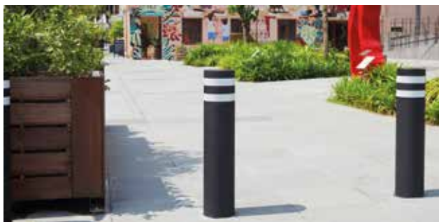
Zdjęcie 13. Zastosowanie blokady złożonej z kwietników i bollardów stałych.
