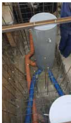
Zdjęcie 16. Przykłady prawidłowego montażu bollardów automatycznych (A i B).
