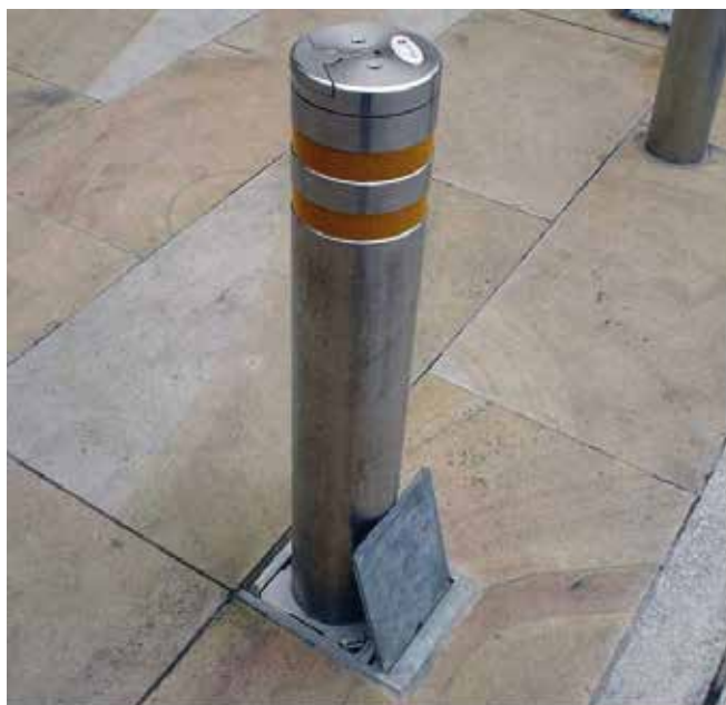
Zdjęcie 8. Bollard sterowany ręcznie.
