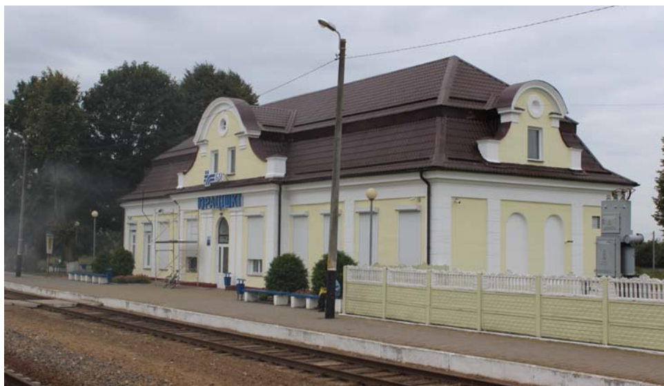
Ryc. 11. Budynek stacyjny na stacji Juraciszki (fot. A. Massel, 2016 r.).
