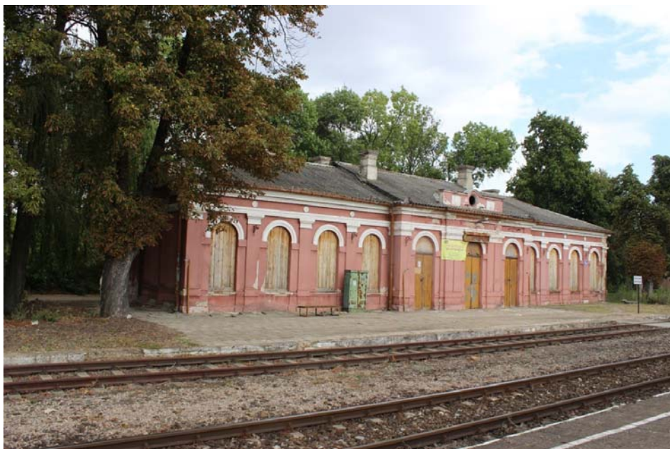
Ryc. 9. Budynek dworca w Mordach (25 sierpnia 2015 r.).
