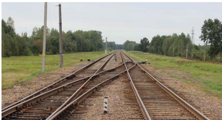
Ryc. 12. Głowica rozjazdowa stacji Juraciszki na odcinku Lida – Mołodeczno (fot. A. Massel, 2016 r.).
