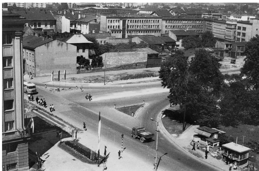
Il. 9. Rzeszów. Skrzyżowanie ul. Grunwaldzkiej i al. Lenina (współcześnie al. Piłsudskiego). Lata 60. XX w. (źródło: Podkarpacka Historia, https://www.podkarpackahistoria.pl/galeria7,rzeszow-lat-60-xx-wieku , dostęp: 14.10.2020)
