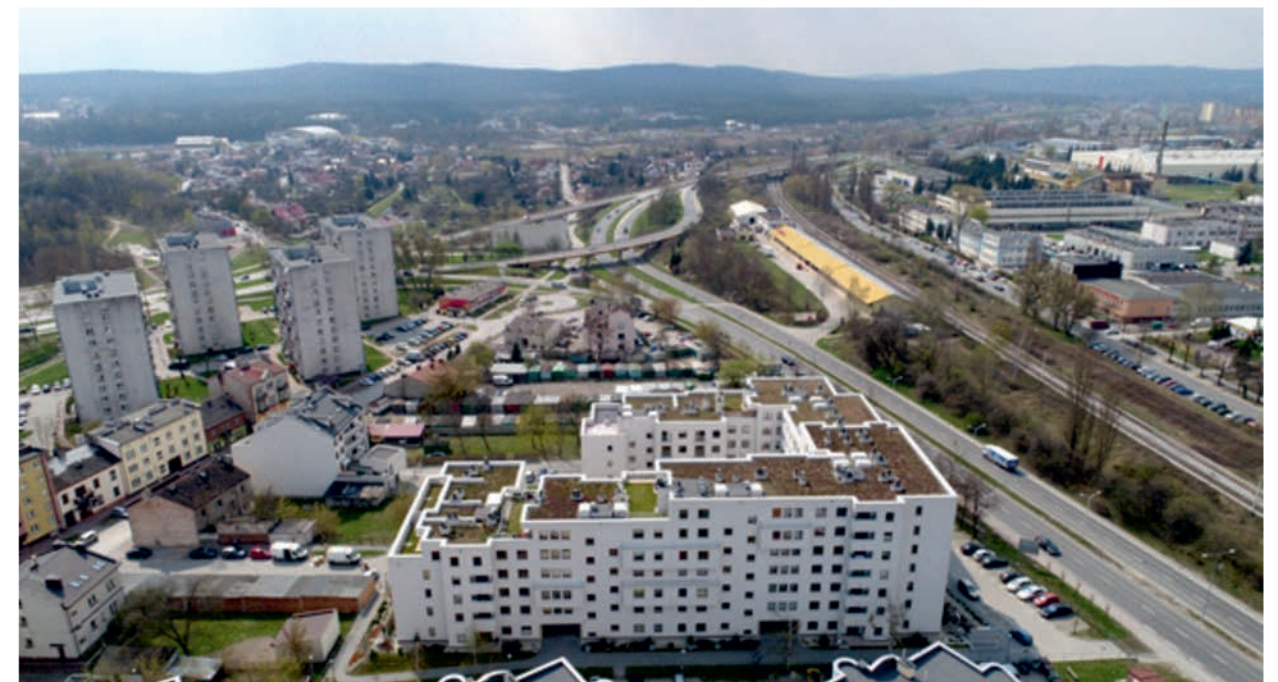
II. 5. Osiedle Galene House. Kielce. Zdjęcie z drona. Materiały udostępnione przez Autorską Pracownię Projektową Regina Kozakiewicz-Opałka III. 5. Galene House housing estate. Kielce. A photograph taken with a flying drone. Materials provided by Regina Kozakiewicz-Opałka Design Studio
