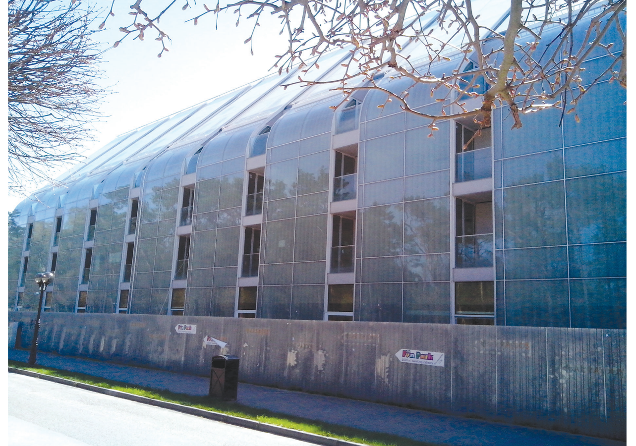
II. 4. Hotel Palace w Pobierowie (stan 2015 r., przed ukończeniem budowy). Źródło: materiały własne autora III. 4. The Palace hotel in Pobierowo (2015, unfinished). Source: The author
