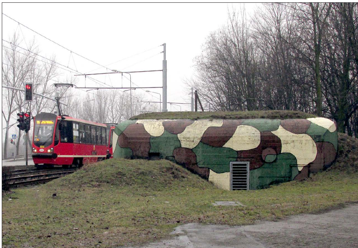
Ryc. 3. Schron Obszaru Warownego „Śląsk” przy trasie tramwajowej w Łagiewnikach.
