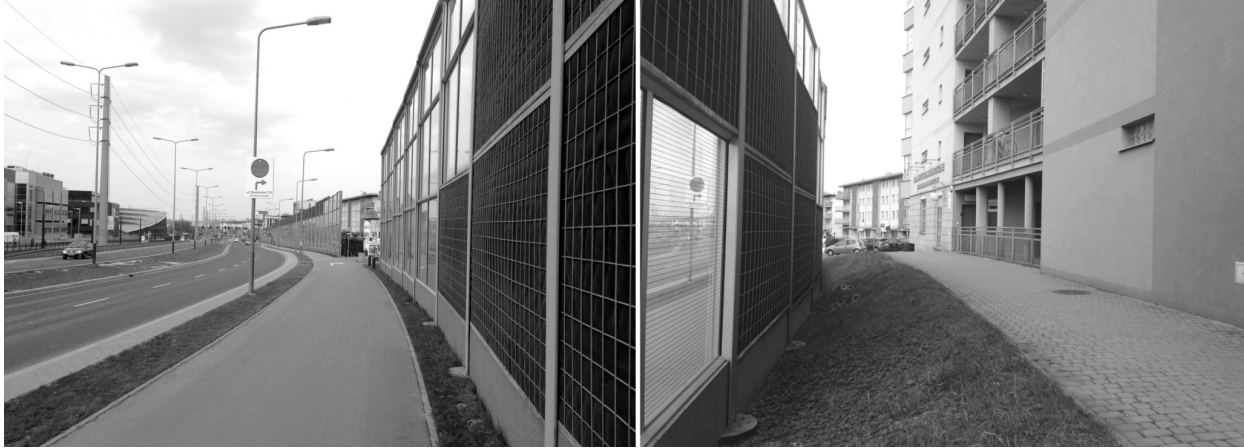
Il. 6. osiedle Ruczaj – główna ulica Grota-Roweckiego z ekranami akustycznymi oddzielającymi ją od zabudowy mieszkaniowej ill.6. the Ruczaj housing estate – the main street – Grota-Roweckiego Street – with acoustic screens separating it from residential buildings
