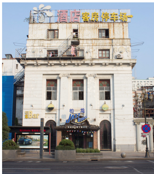
Il. 8. Budynek dawnego konsulatu brytyjskiego w Hankou zniszczony przez samowole budowlane. Le consulat anglaise, [w:] Quartier Anciennes de concession de Wuhan (źródło: http://www.village-ginkgo.com/quartier-des-anciennes-concessions-a-wuhan/ )
