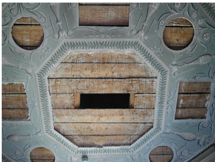
II. 5. Gabinet w wieży, sufit pomieszczenia przed rozpoczęciem prac (fot. K. Szkodlarska, 2015)
