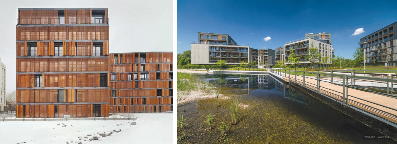
Il. 5. Apartamenty Wilanowska w Warszawie – widok na kompozycję elewacji która zmienia się w czasie kiedy mieszkańcy dostosowują intensywność światła wpadająca do wnętrza swoich mieszkań (źródło zdjęć: rogowski.development.pl, jems.pl) / “Wilanowska Apartments” in Warsaw – the view on the front cover composition which changes in time when the residents adjust the intensity of light coming into their flats (source of photos: rogowski.development.pl, jems.pl)
