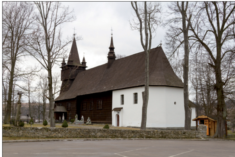
Il. 2. Kościół w Orawce. Widok od strony południowo-zachodniej. Fot. I. Borczuch
