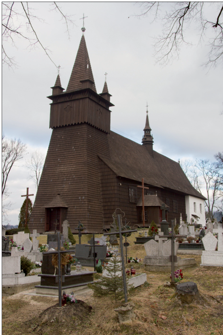
Il. 1. Kościół w Orawce. Widok od strony południowo-wschodniej. Fot. I. Borczuch
