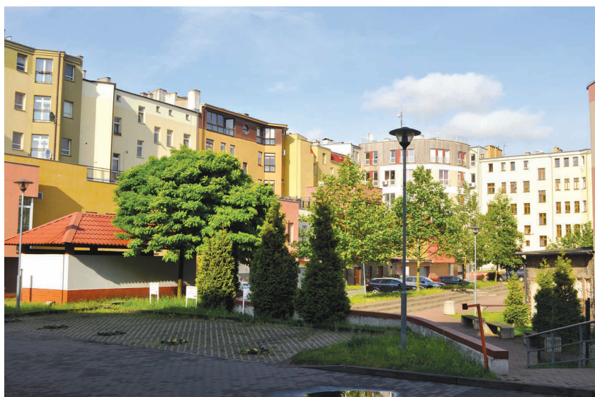
II. 4. Wnętrze kwartału nr 22 po rewitalizacji – nowa zabudowa oficynowa kamienic przy ul. Jagiellońskiej (fot. I. Kozłowska)
