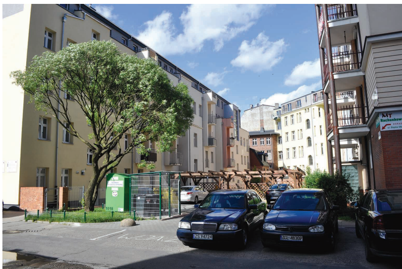
II. 6. Wnętrze kwartału nr 40 po rewitalizacji – nowa zabudowa oficynowa kamienic przy ul. Śląskiej (fot. I. Kozłowska)
