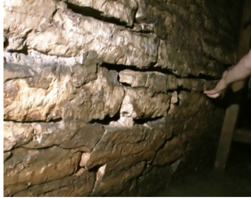
Fig. 1. Fryderyk” (“Kościuszko”) adit inlet portal (made 02.08.2016)
