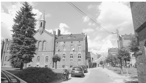
II. 2. Neogotyckie zabudowania pierwszej fazy budowy zakładu w Świeciu, po lewej stronie budynek zaplecza gospodarczego (m.in. kuchni), po prawej – pawilony. Fot. A. Staniewska, 2014
