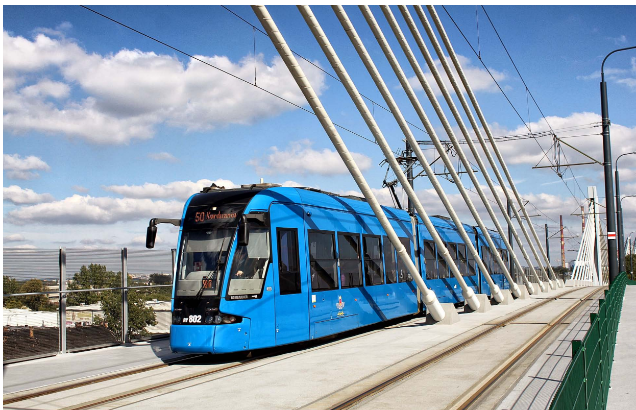
Ryc. 4. Estakada nad stacją kolejową Kraków Płaszów
