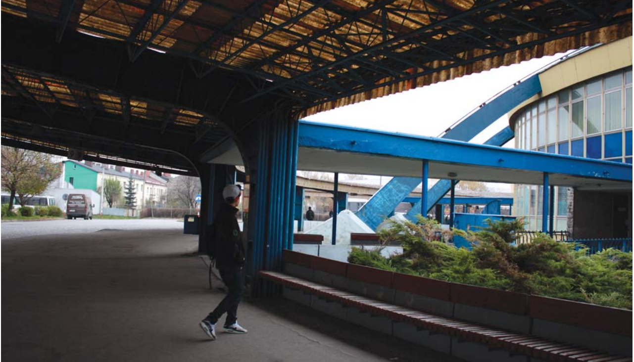
il. 8 Dworzec autobusowy, stan obecny. Fot. Edyta Banachowska, listopad 2014 / Kielce Bus Station, the current state. Phot. Edyta Banachowska, November 2014
