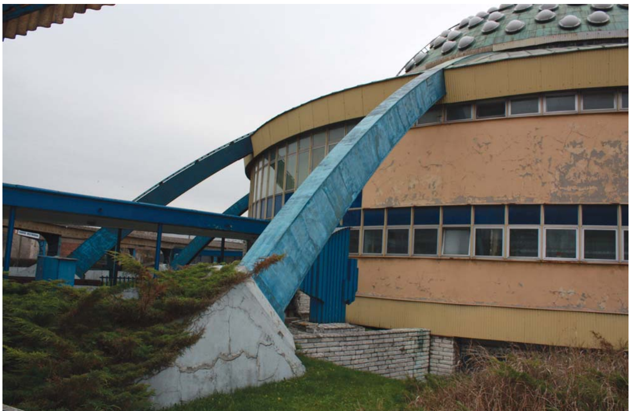
il. 9 Dworzec autobusowy, stan obecny. Fot. Edyta Banachowska, listopad 2014 / Kielce Bus Station, the current state. Phot. Edyta Banachowska, November 2014
