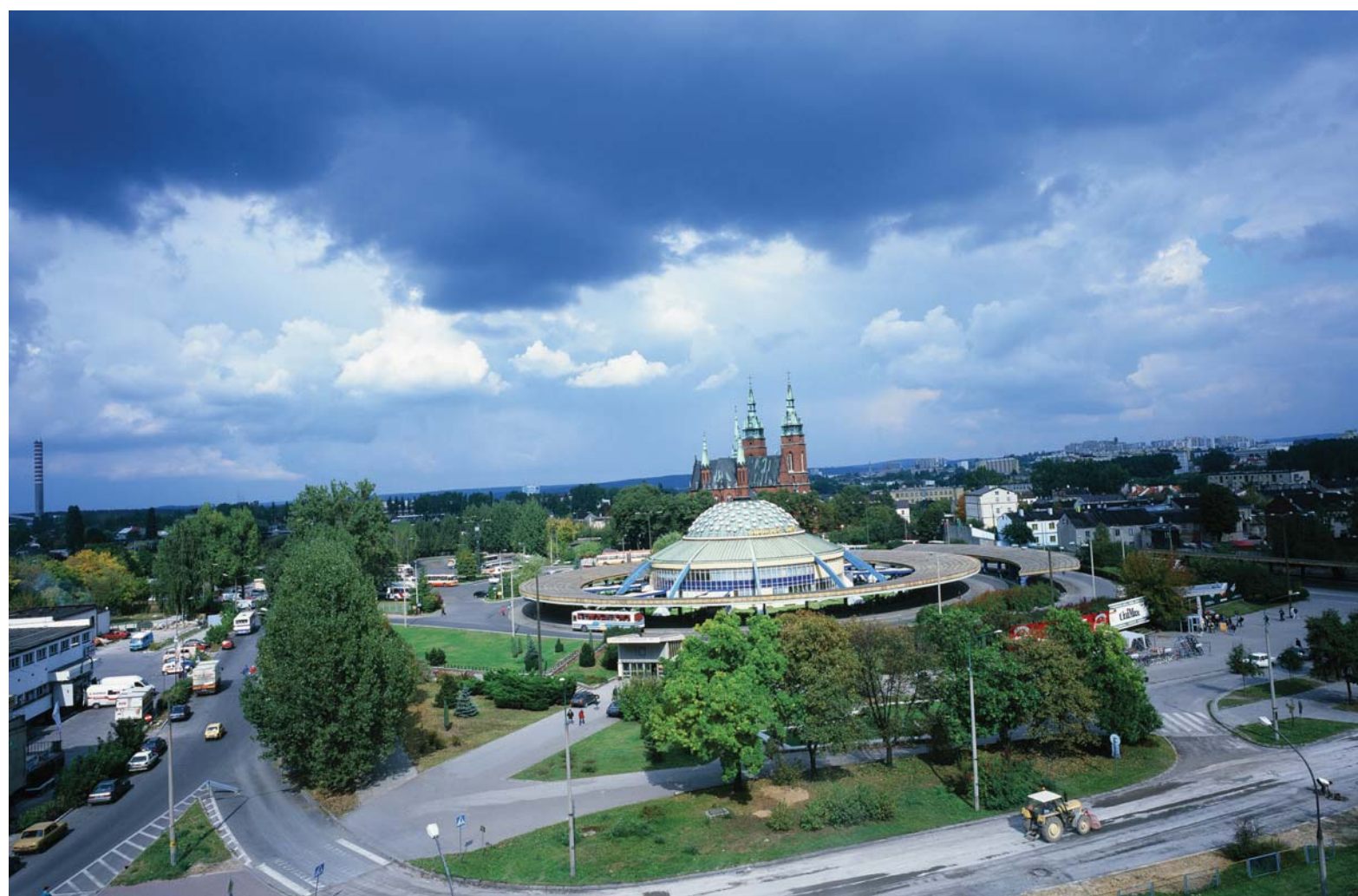
il. 1. Dworzec autobusowy w latach świetności. Fot. Paweł Pierściński / Kielce Bus Station in times of its magnificence. Phot. Paweł Pierściński
