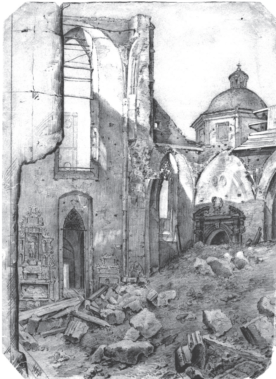
Ryc. 2. Maksymilian Cercha, Wnętrze kościoła dominikanów po zawaleniu się sklepienia, rys. 1855. MHK 1997-VIII
