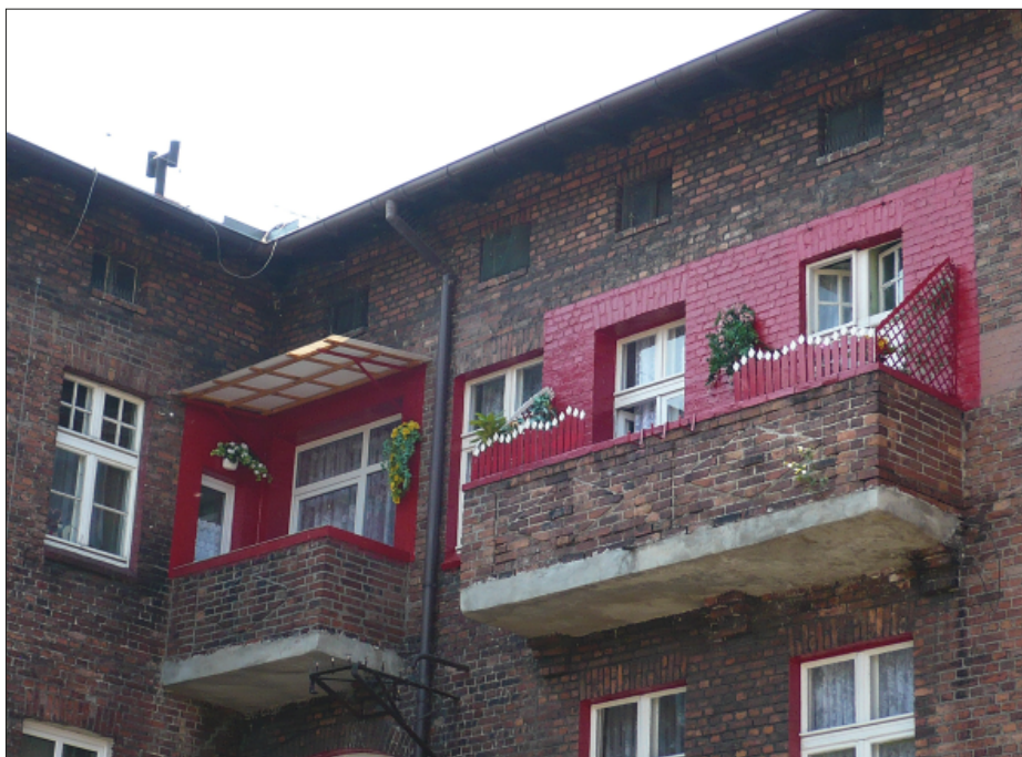
Fot. 3. Przykład remontów dokonywanych przez mieszkańców (fot. A. Pudełko) Photo 3. Example of repairs undertaken by the owners of their own initiative (photo by A. Pudełko)
