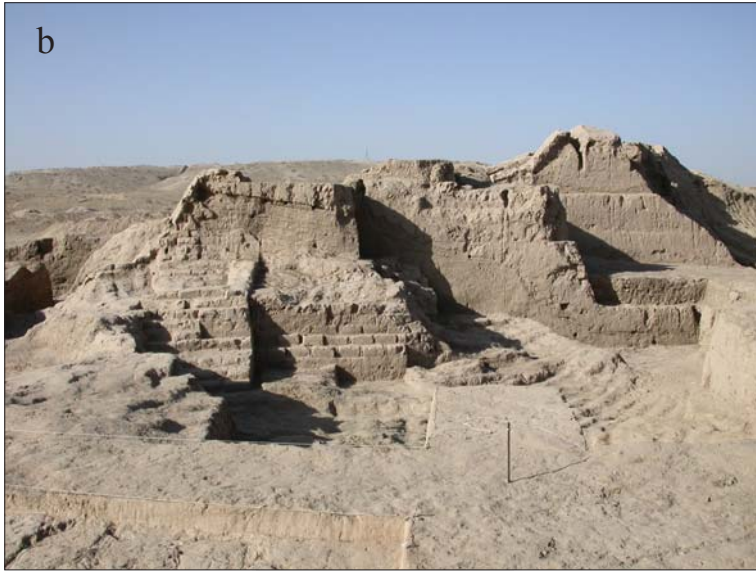
Fig. 11b. Coupe sur la partie sud détruite du palais après retaillage. Noter la plateforme de pisé du troisième état reposant sur l'épaisse accumulation de sable éolien ennoyant les deux premiers états du bâtiment. Vue vers le Nord ; © MAFOuz de Bactriane
