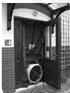
Fig. 2a. Blowerdoor fan – external view
