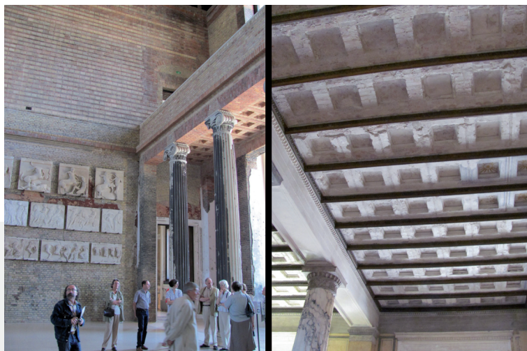
II. 5. Detale portyku od strony zachodniej przy głównej klatce schodowej oraz fragment zachowanego stropu z cegły (fot. E. Węclawowicz-Gyurkovich)
