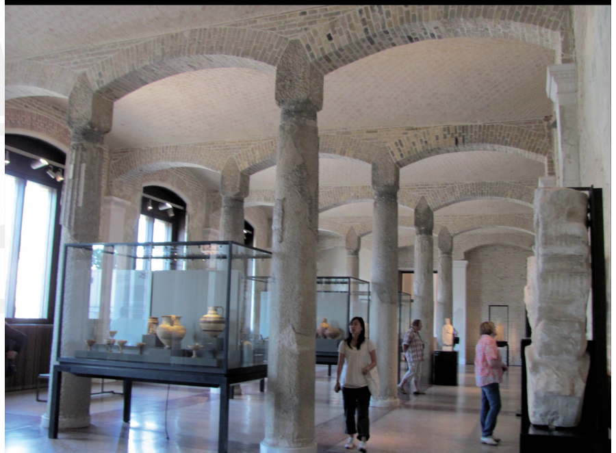
II. 9. Detale sal, gdzie widoczne są przetarcia polichromii i uszczerbienia kolumn w Sali Etnograficznej (fot. E. Węclawowicz-Gyurkovich)
