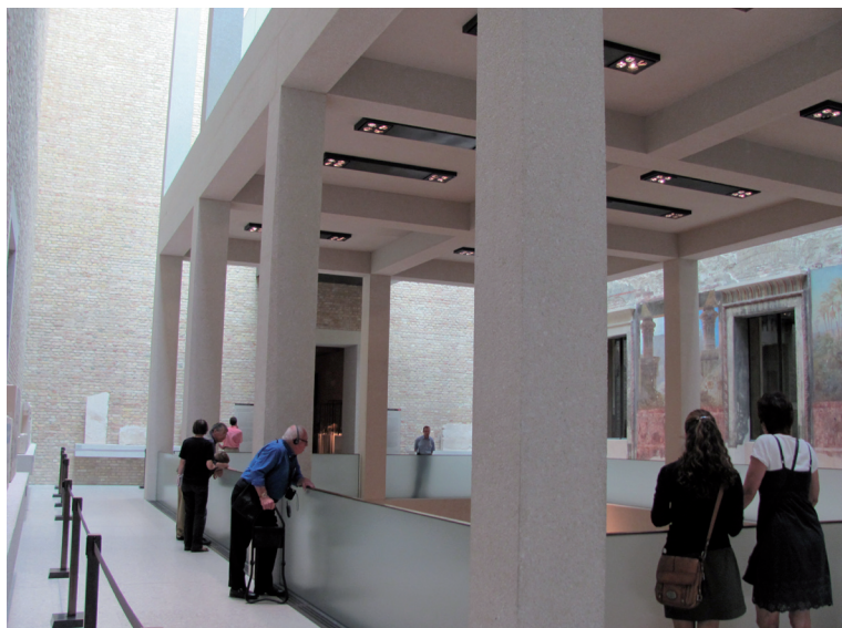
Il. 7. Nowe filary odtworzonego dziedzińca Egipskiego z widocznymi zachowanymi fragmentami polichromii na ścianach bocznych (fot. E. Węclawowicz-Gyurkovich)
