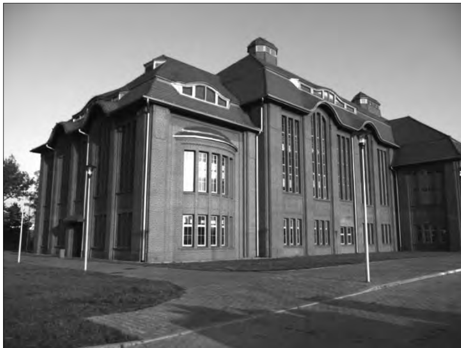
Ilustracja 6. Przykład adaptacji budynku pokopalnianego (maszynowni) na potrzeby inkubatora przedsiębiorczości
