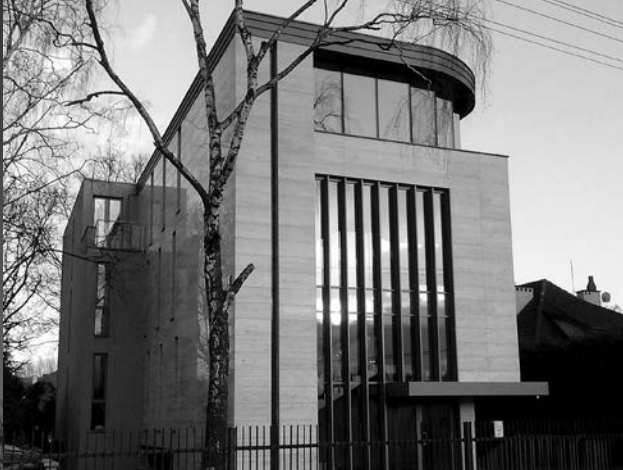
il. 20. Zdjęcie od strony wejścia do budynku przy ulicy Jesionowej 3 (fot. autora) / Photo from the entrance to the building at 3 Jesionowa street (photo by the author)
