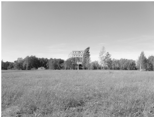
II. 4. Fragment zrewitalizowanego terenu kopalni Concordia. Fot. K. Łakomy, 2015
