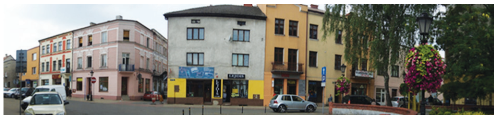
II. 9. Oświęcim. Zdeprawowana kamienica narożna przy ulicy Klasztornej oraz Mały Rynek, pustostan (fot. K. Paprzyca) 18
