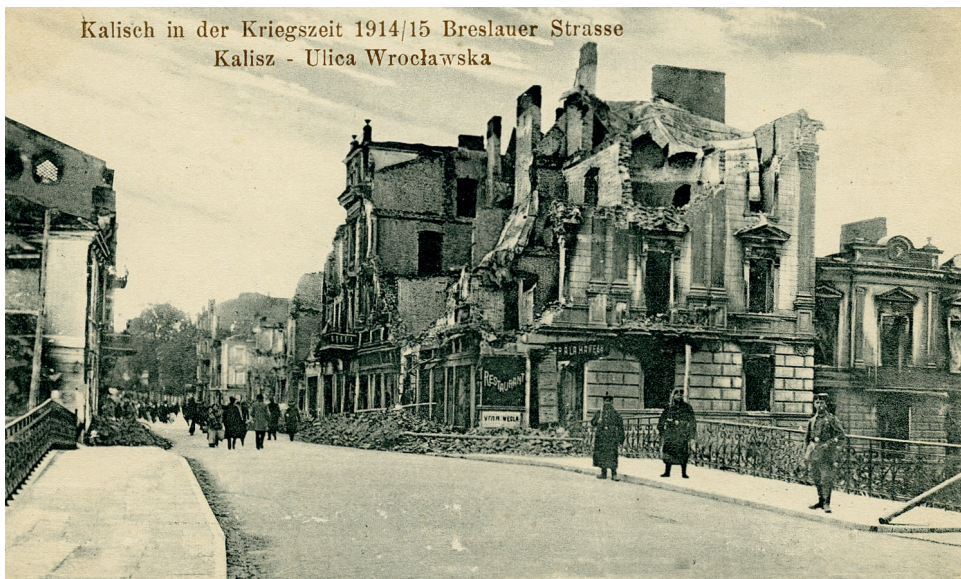
Fot. 6. Most Reformacki na przełomie lat 1914–1915 ze zburzonymi domami Kalisza w tle, na pocztówce bez obiegów, Verlag O. Witzel, Photogr. Atelier, Krotoschin i. P. (ze zbiorów autora).
