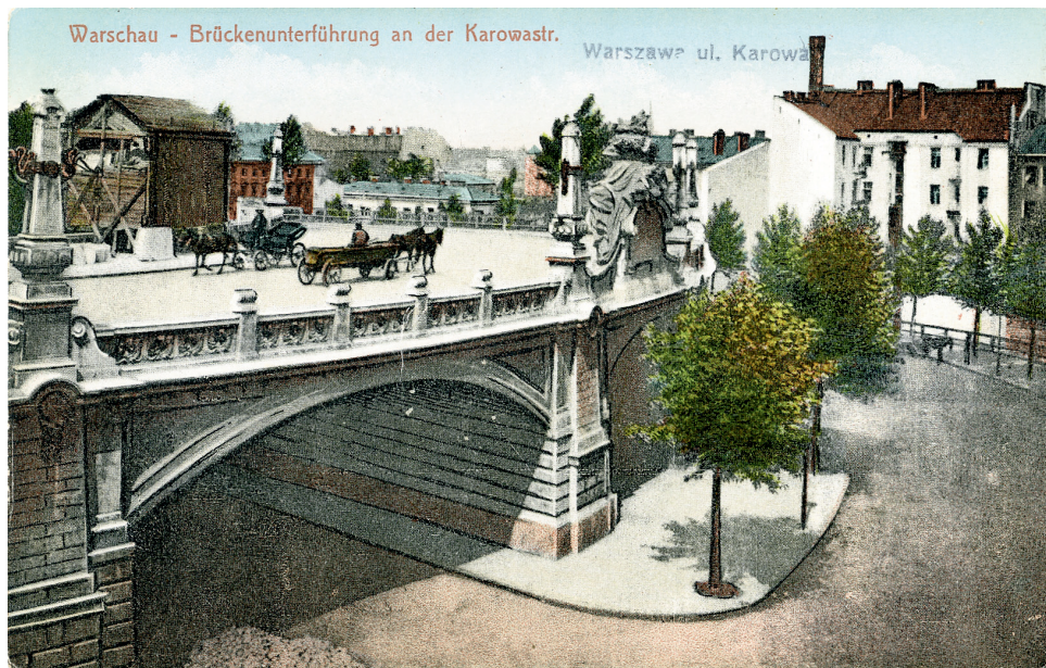
Fot. 9. Wiadukt na Karowej po zajęciu Warszawy przez Niemców w okresie pierwszej wojny światowej na pocztówce bez obiegów, bez wydawcy (ze zbiorów autora).
